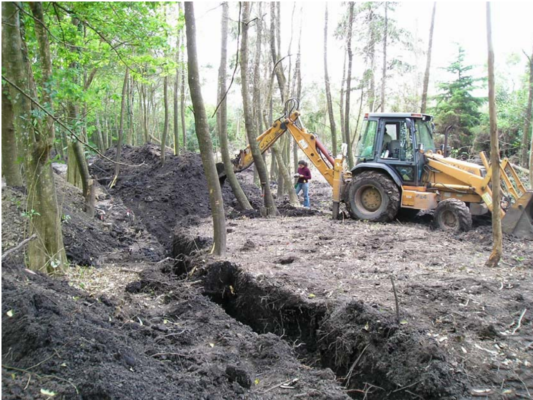
Figura 13, Tareas de excavación con pala mecánica.
