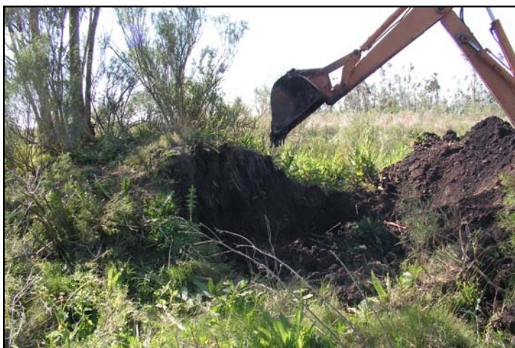
Figura 8. Excavación de túmulo.
