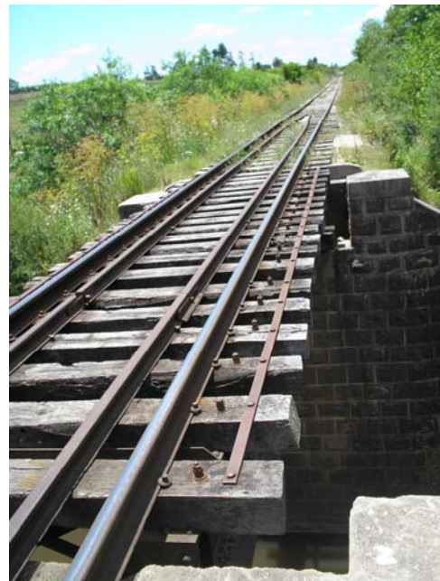
Figura 2 – Vista panorámica del puente sobre el Arroyo Meireles.
