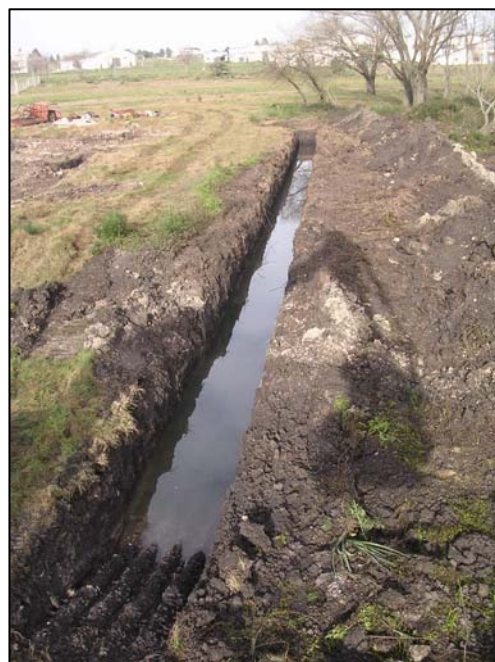
Fig 35: Trinchera 1ª etapa
