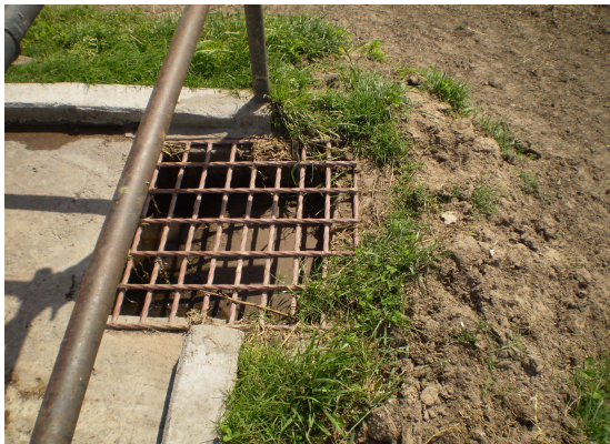
Figura 12: Cámaras de retención de sólidos
