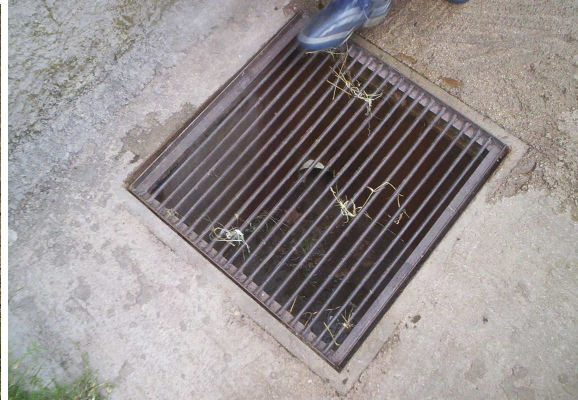
Figura 12: Cámaras de retención de sólidos
